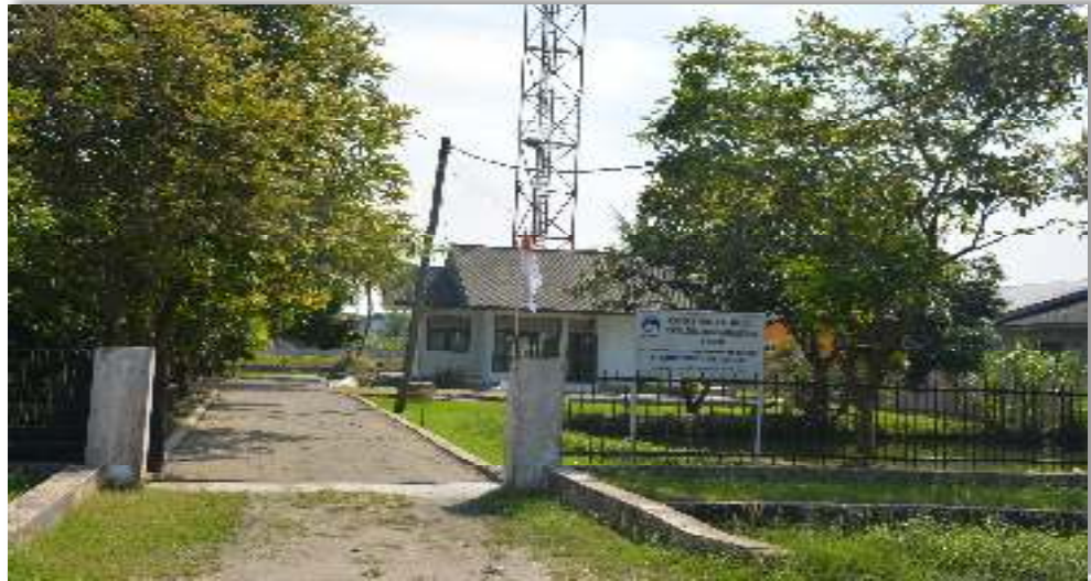
Gambar 3.14 Stasiun Slave V-UHF Percut, Kec. Percut Sei Tuan
