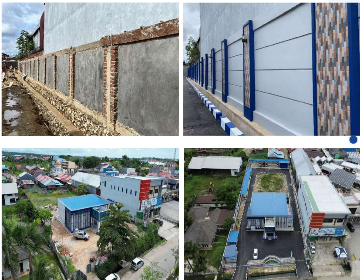
Gambar 3.23 Progres Pembangunan Fasilitas Perkantoran
