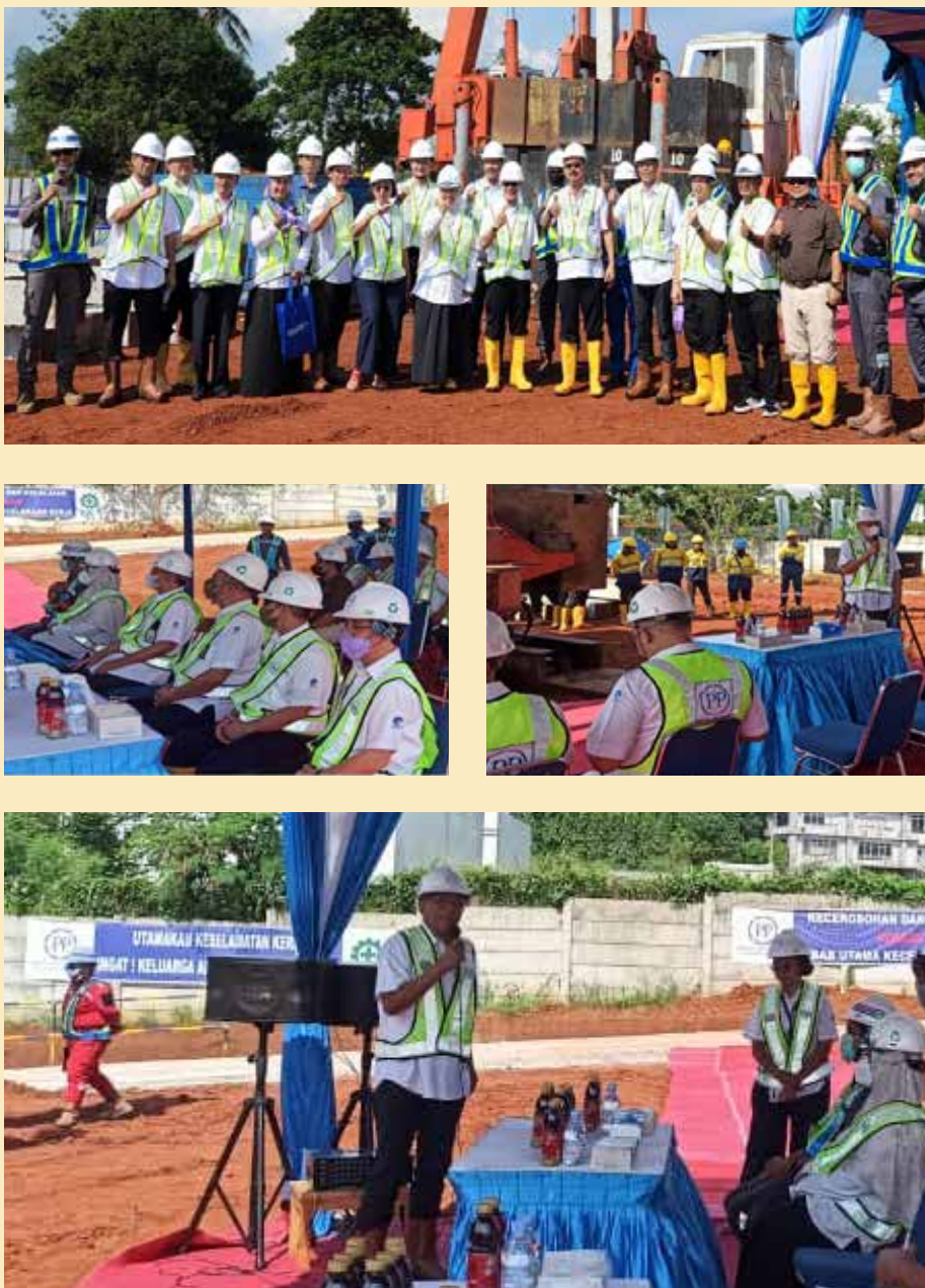
Gambar 3.26 Pemancangan pondasi gedung, 23 Mei 2022
